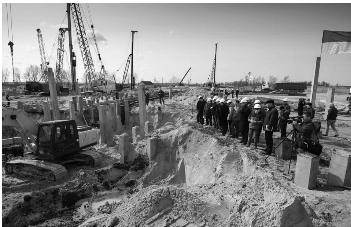
Котлован майбутнього автомобілерозвантажувача.
